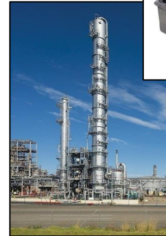
Colonna industriale di distillazione frazionata e piatto interno della colonna
